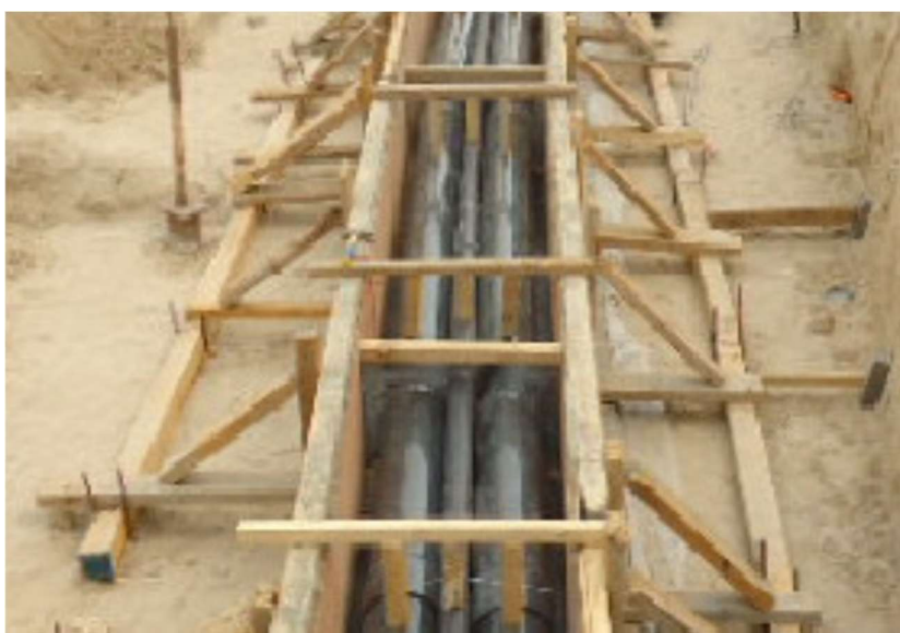
Figura 9-14: Forma Típica de Banco de Dutos
