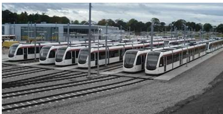
Figura 4-2 - Pátio de estacionamento com via permanente em lastro
