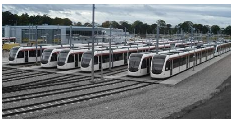
Figura 5.2 - Pátio de estacionamento com via permanente em lastro
