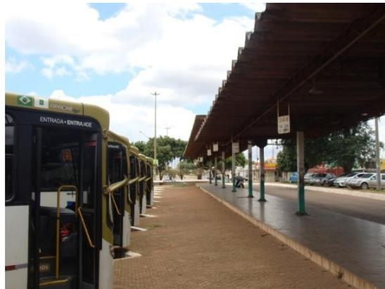
Figura 2: Cobertura Insuficiente do Terminal Ceilândia P Norte
