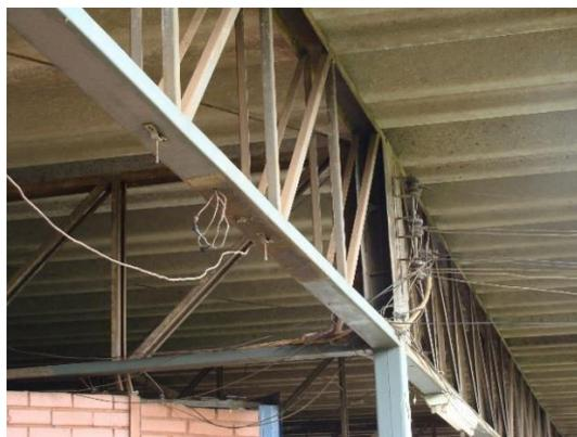
Figura 10 - Fiação exposta no Terminal de Sobradinho Centro
