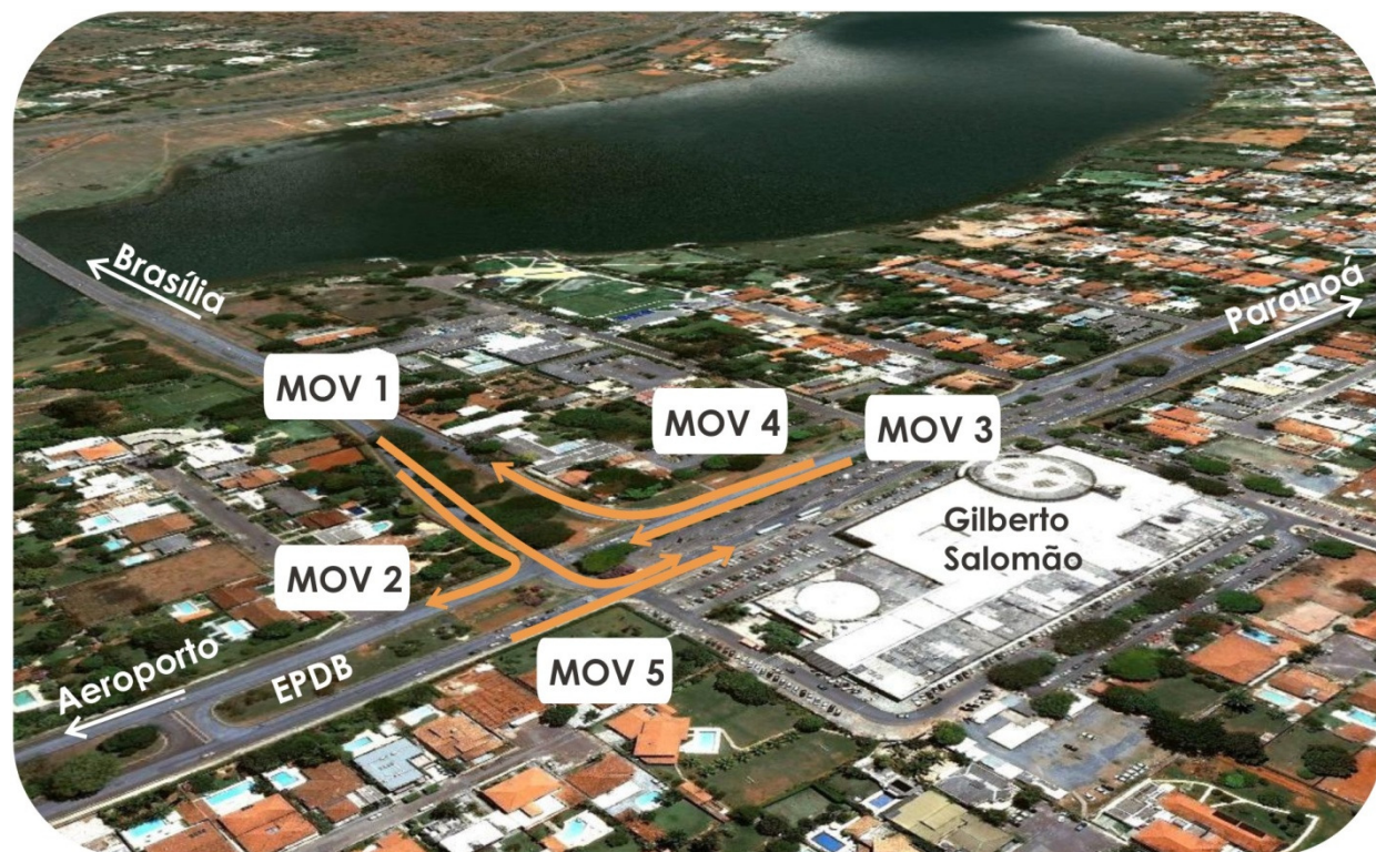
Figura 20: Localização dos movimentos no Ponto 17 – Interseção da DF-025 (EPDB) com o acesso a 1ª Ponte do Lago Sul - Ponte Presidente Médici
