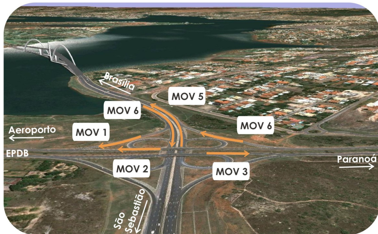
Figura 22: Localização dos movimentos no Ponto 19 - Interseção da DF-025 (EPDB) com acesso a 3ª Ponte do Lago Sul – Ponte JK
