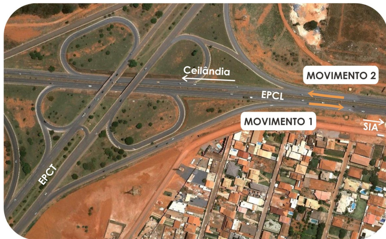
Figura 19: Localização dos movimentos no Ponto 16 - Interseção da DF-001 (EPCT) com a DF-095 (EPCL)
