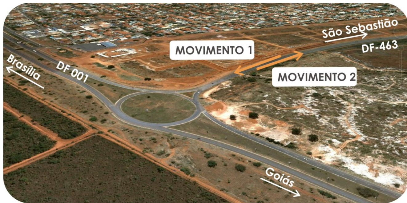
Figura 23: Localização dos movimentos no Ponto 20 - Interseção da DF-001 (EPCT) com a DF-463, Balão de acesso à São Sebastião
