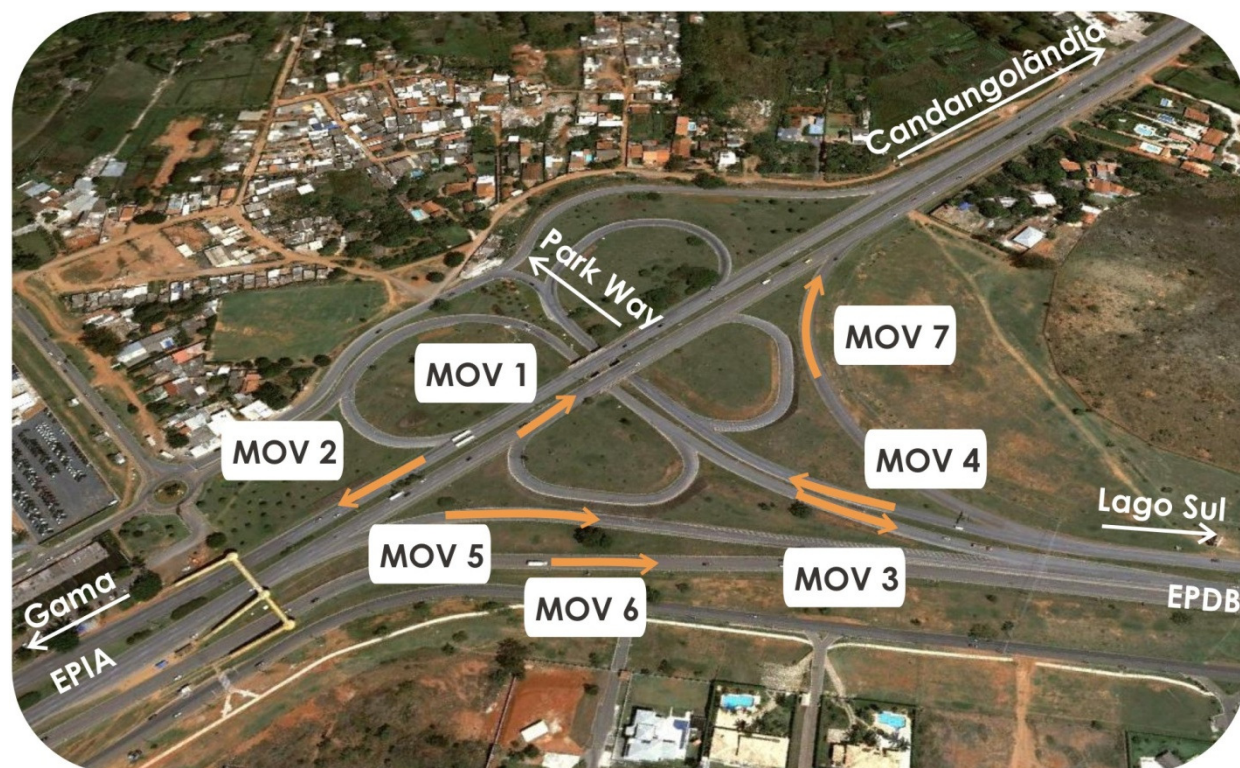
Figura 18: Localização dos movimentos no Ponto 15 – Interseção da DF-025 (EPDB) com a DF-003 (EPIA)
